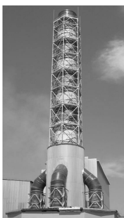
Рис. 17. Дымовая труба на металлургическом заводе им. Серова
