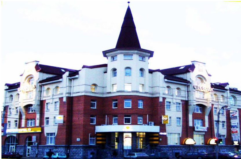
а) офисное здание «Джемир». Общий вид
