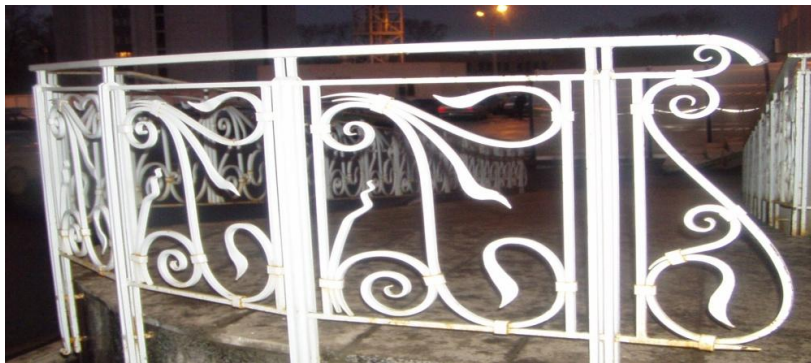
б) ограждение балкона
