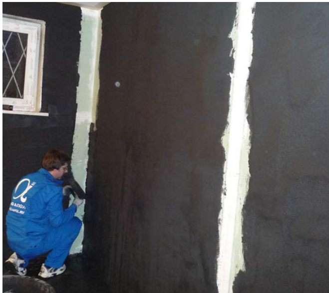
Рис. 7. РПМ на основе бетона
