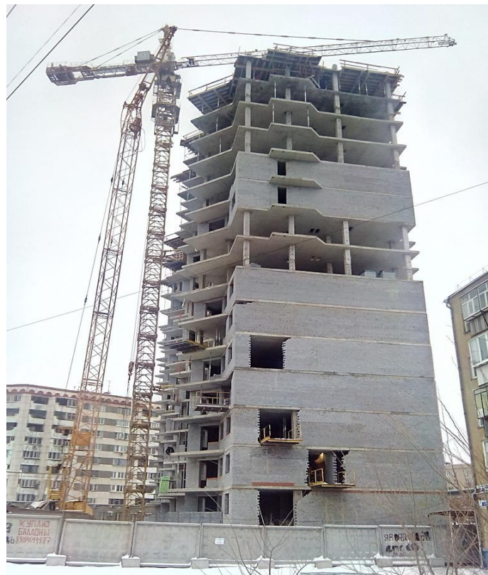
Строящееся каркасно-монолитное здание
