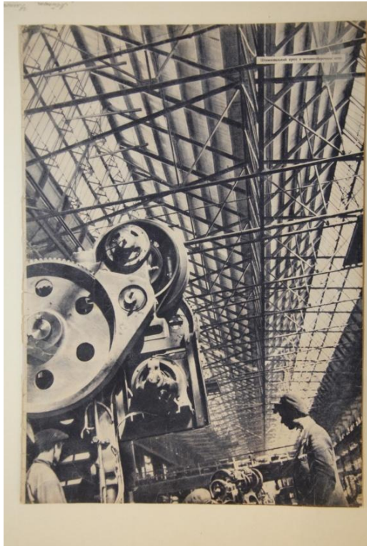
Рис. 1. Механосборочный корпус Челябинского тракторостроя, вид изнутри, фото 1933 г. [2]
