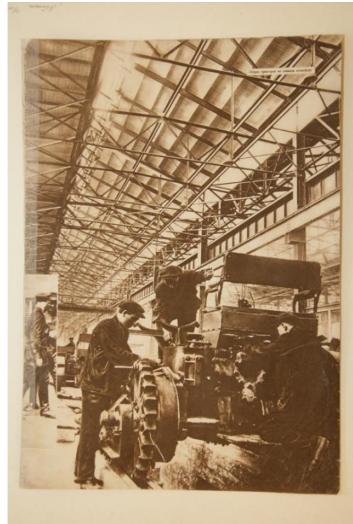
Рис. 2. Механосборочный корпус Челябинского тракторостроя, вид изнутри, фото 1933 г. [2]
