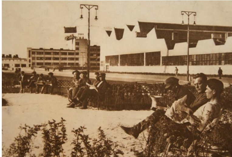
Рис. 3. Механосборочный корпус Челябинского тракторостроя, фото 1933 г. [2]
