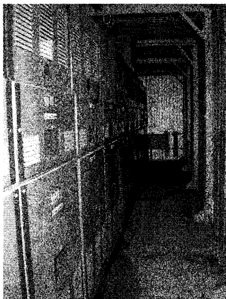
Рис. 2. РУ-10(6) кВ, где между ячейками с электрооборудованием и стеной существует проход
