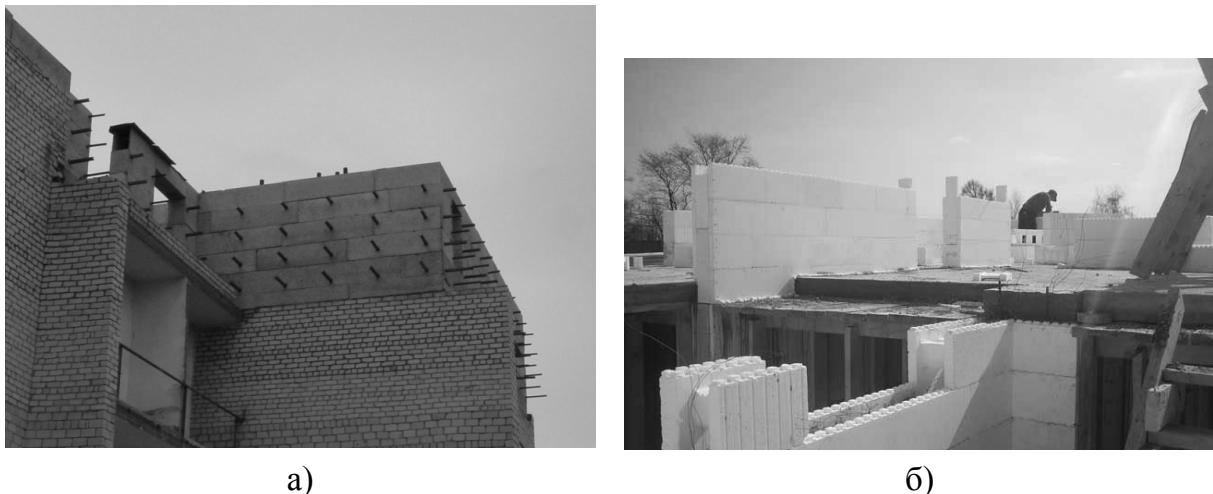
Рис. 1. Применение несъемной опалубки при возведении жилых зданий: а – несъемная опалубка из стекло-магнезиальных листов; б – несъемная опалубка из пенополистирольных блоков
