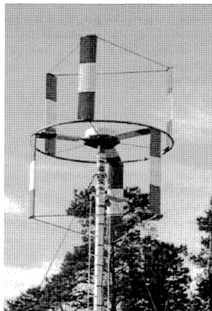
Рис. 1. Ветроэнергетическая установка с вертикальной осью вращения
